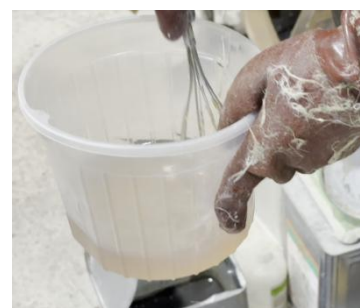
図 樹脂を混練する様子
