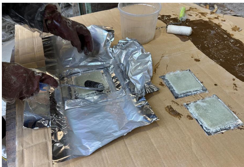
図 GFRP 積層の様子
