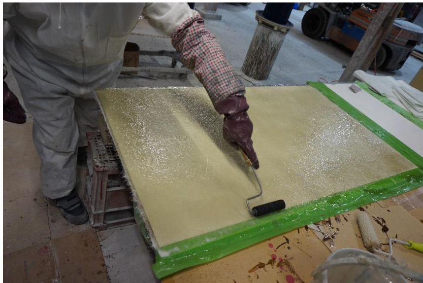
図 FRP 平板を積層している様子
